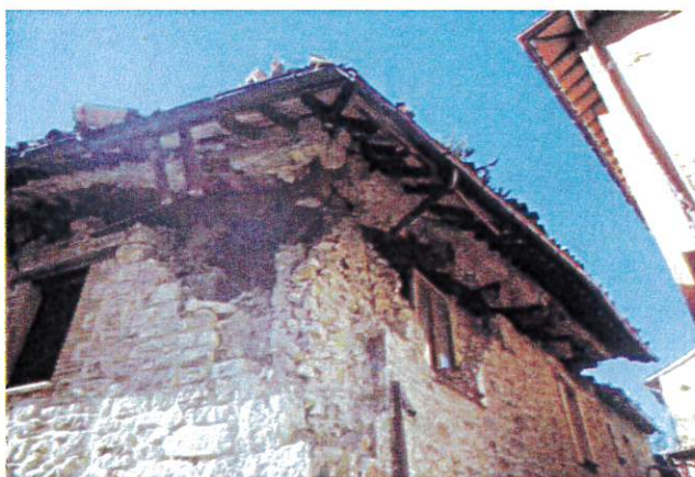
Figura 21 Comportamento di tetto con orditura a puntoni lignei a spinta non compensata. Visso (MC).
