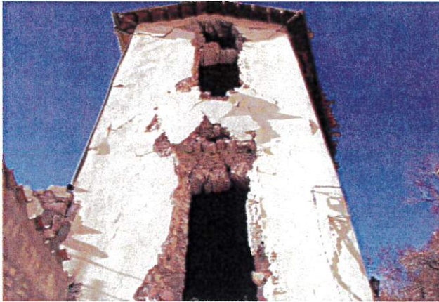
Figure 19-20 Palazzo Terenzi a Castelsantangelo sul Nera. Il fronte dopo la caduta dei contorni in pietra e gli elementi lapidei a terra.
